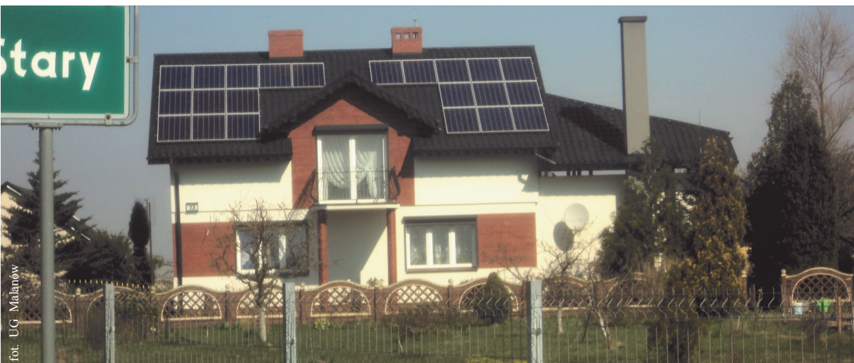
Instalacja fotowoltaiczna zainstalowana na nieruchomości
