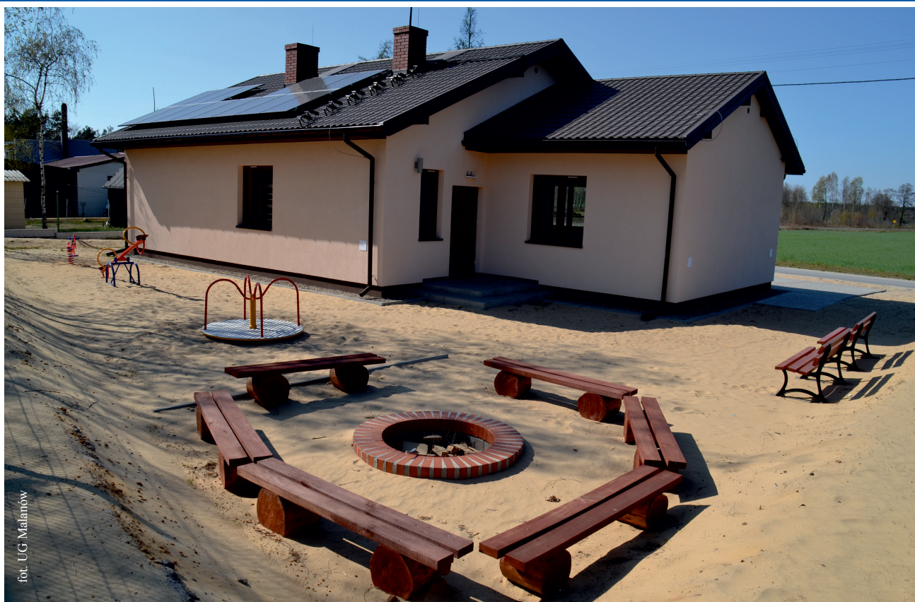
Świetlica Wiejska w Celestynach
